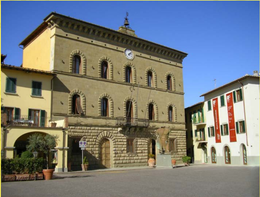
Palazzo Comunale di Greve in Chianti
